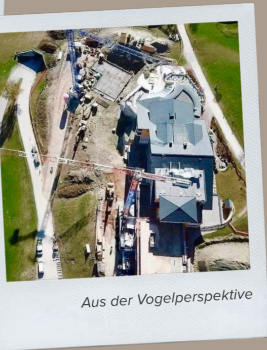
Die ersten Wände stehen
